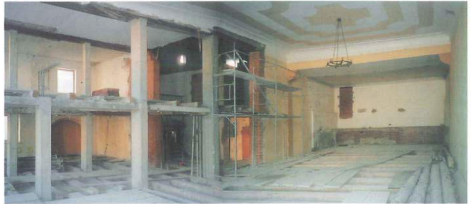
Umbau Bühne und Galerie
